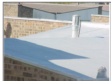
Asbestos flue
