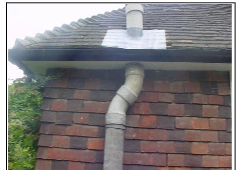
Asbestos Flue
