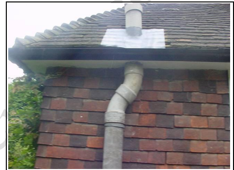
Asbestos flue
